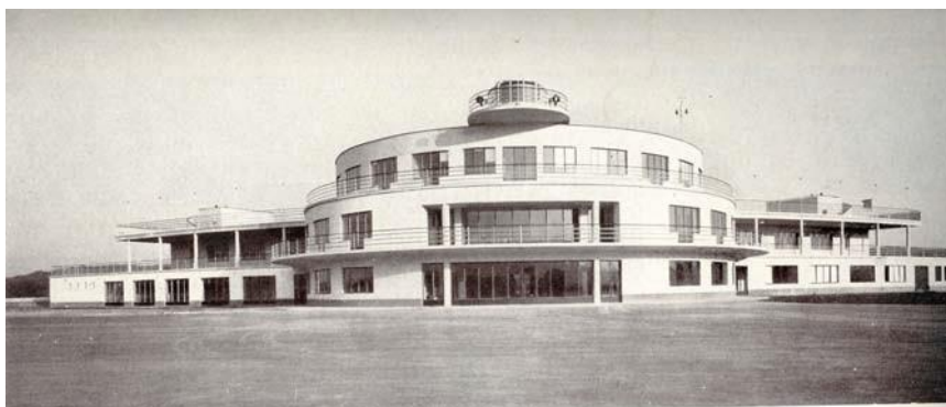
5. ábra A Budaörsi repülőtér utasforgalmi épülete 9
