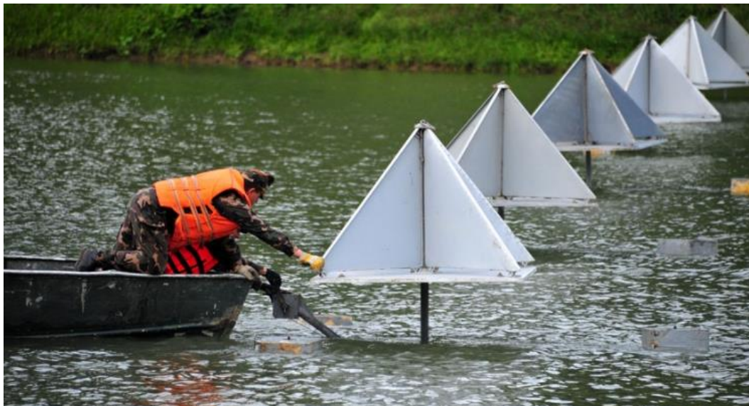
4. kép PIRAMIDA szögviszaverő eszköz telepítése a Tiszán [12]
