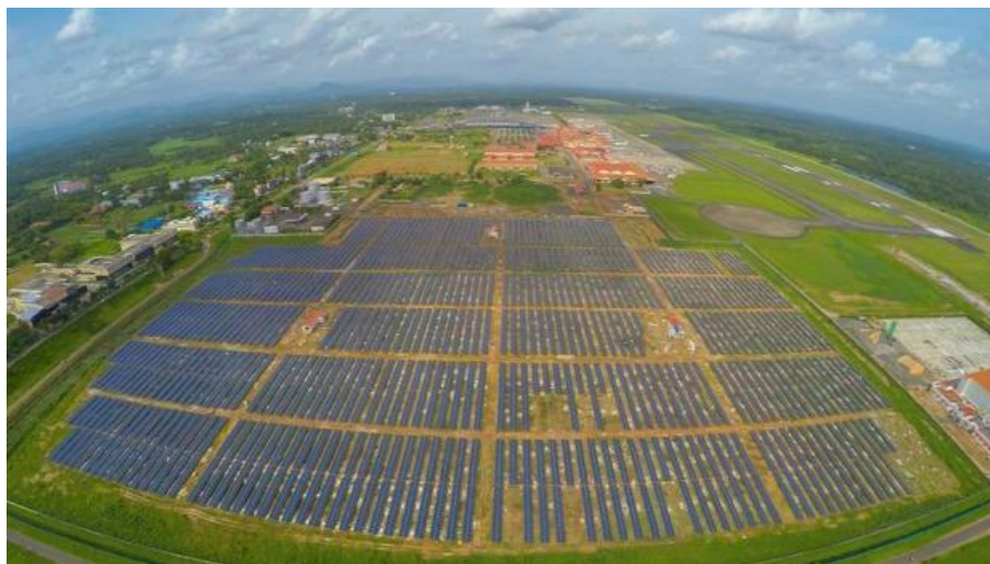
37. ábra A Cochin Nemzetközi Repülőtér 45 hektáros napelemrendszere [Fotó: Cochin International Airport]
