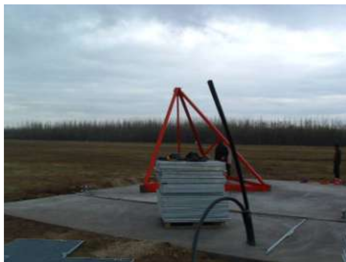
4. ábra. A lokátorantenna tornyának alaptestje
