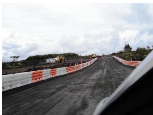
Ideiglenes út építése 18
