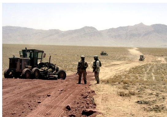
Megközelítési út építése 19
