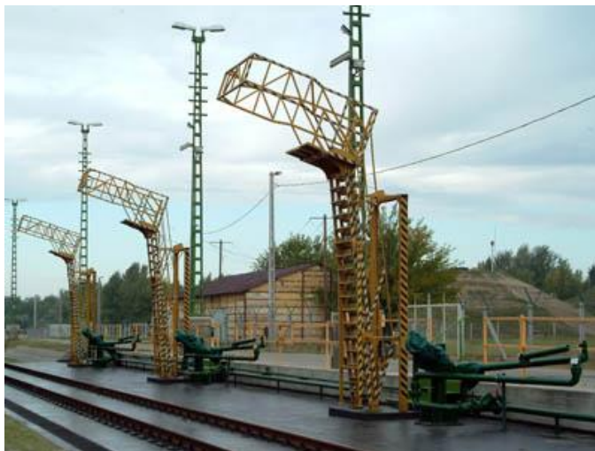
10. ábra: Korszerű vasúti üzemanyag lefejtő rendszer a kecskeméti repülőtéren 16
