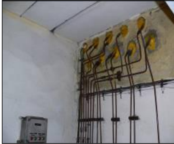
2. kép. Gáztömörséget biztosító megoldás [7]
