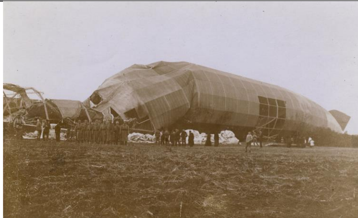
41. ábra A sérült hajó szétszedése közben
