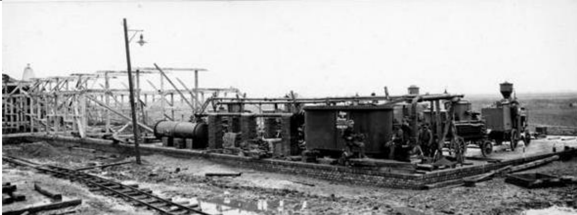
30. ábra A léghajóbázis gázgyára építés közben. Jól látható, hogy két tábori berendezést helyeztek el benne, melyeket tartályokkal egészítettek ki
